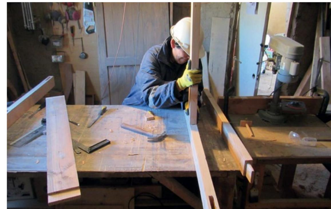
3. Cuando el daño era menos del 80% se procedió a restaurar el elemento. Si se trataba de un colapso y/o erosión se sustituyó la pieza por una en buen estado. Si se debía al desplazamiento respecto al eje, se colocó en la posición correcta. Las pinturas en mal estado se liberaron del soporte y se volvieron a pintar.
