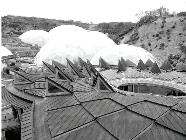
Imagen 127. Cubierta de cobre en edificio de viviendas anónimo.
