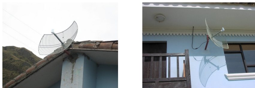
Figura 7.4: Montaje de antena en pared.
